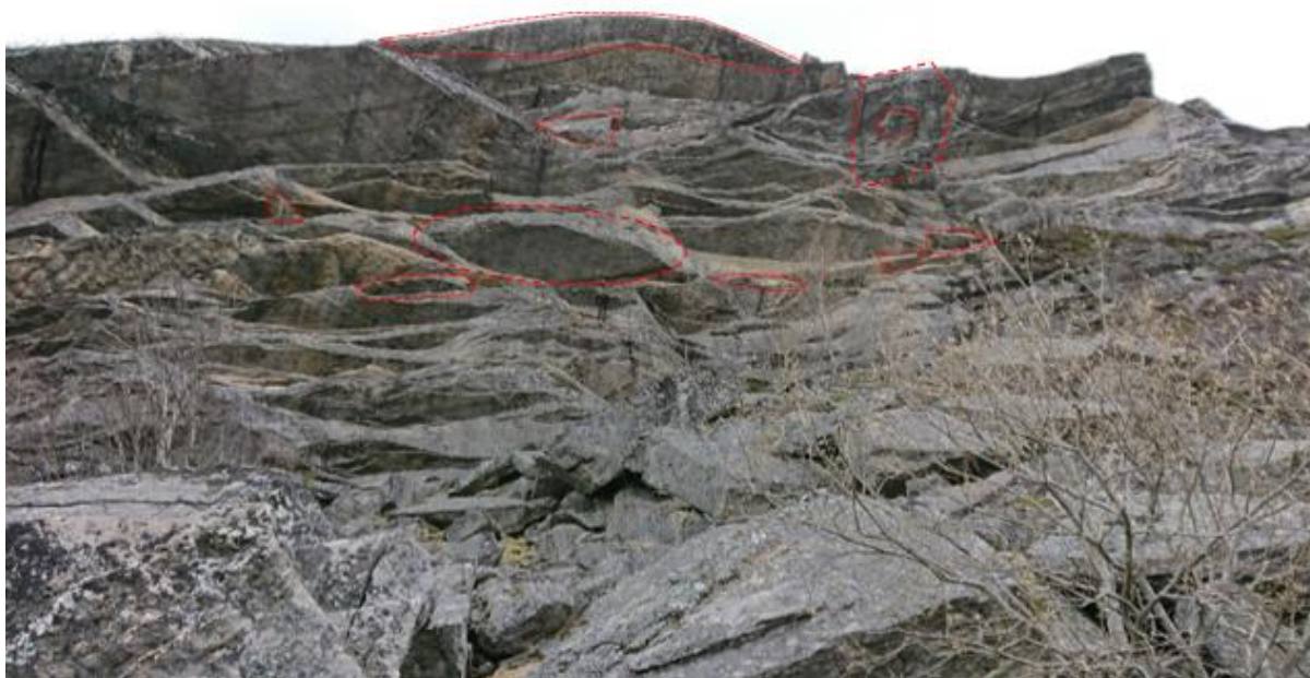
Figur 26: Lokaltet 4 - Potensielt løse blokker er markert
