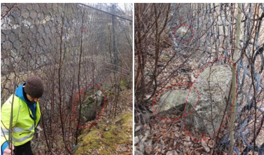
Figur 33: Lokalitet 8: Eksempler på nedfall som er fanget opp av fangnettgerde
