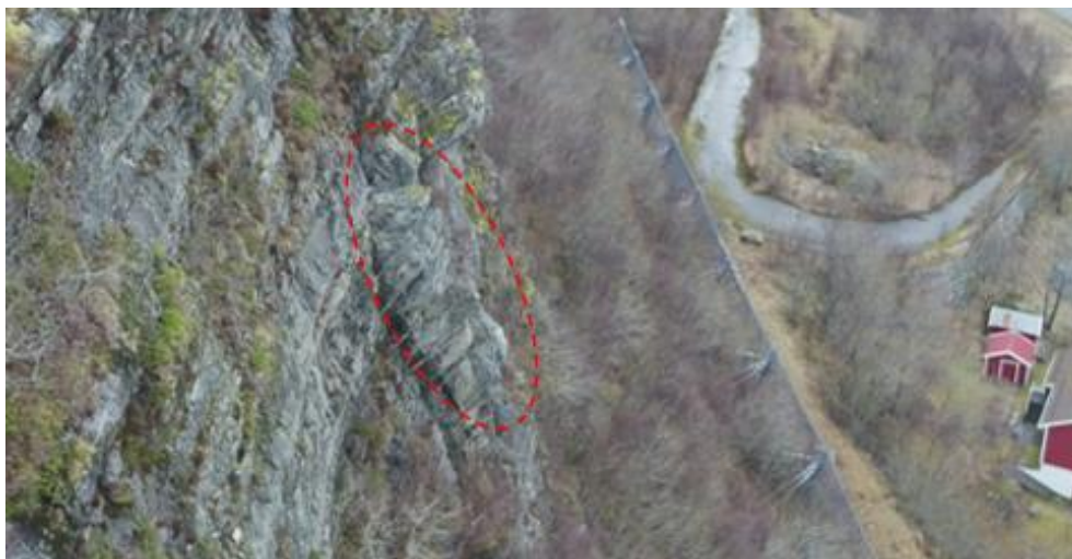
Figur 31: Lokalitet 7 b): Rygg med løse blokker, sikret med wirenett og wire
