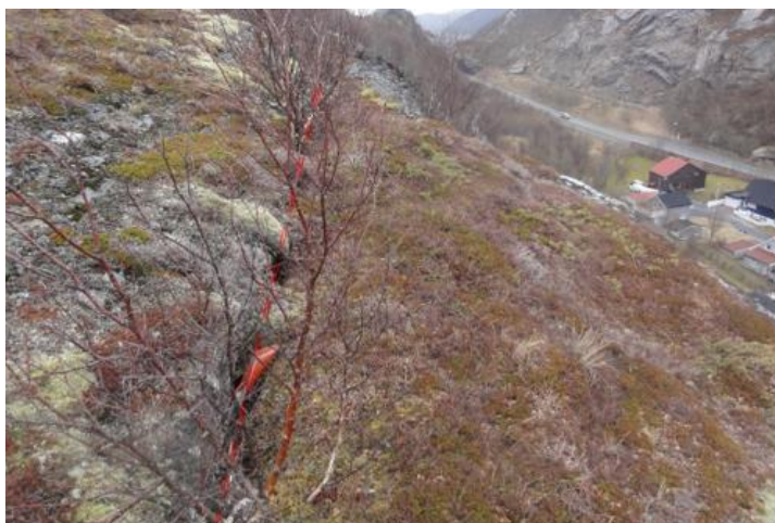
Figur 30: Lokalitet 7 a): Åpen deformasjonssprekk
