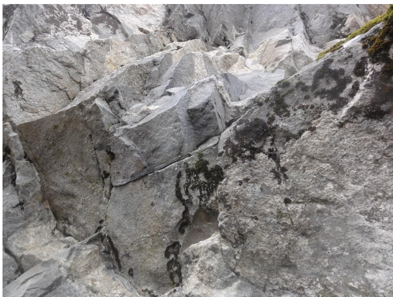
Figur 20: Typisk bergart og bergmassekvalitet i søndre del av skrent.
